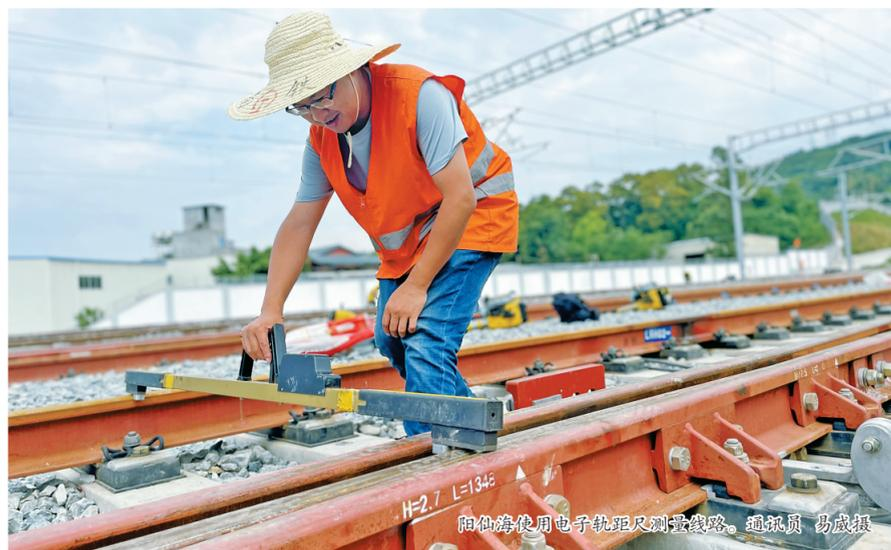
阳仙海使用电子轨距尺测量线路。通讯员 易成摄
