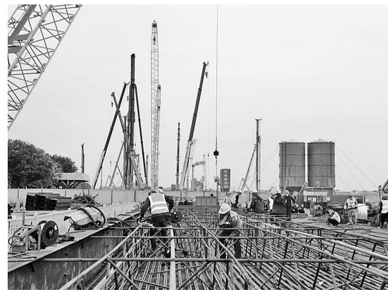
施工人员安装地下连续墙钢筋。(市交建集团供图)
